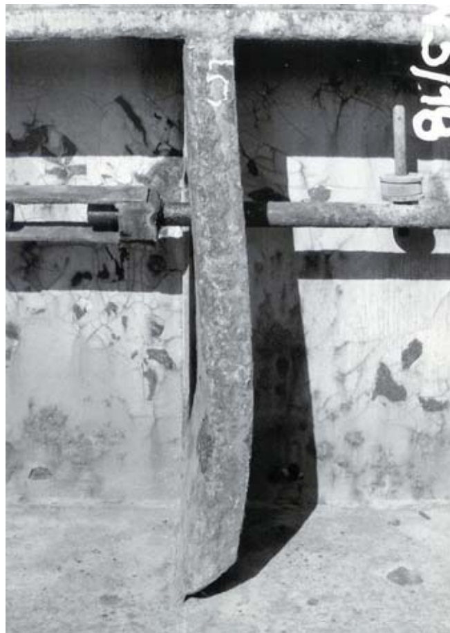
Rys.8. Wyboczenie węzłówki zrębnicy Fig.8. Buckling of coaming bracket
