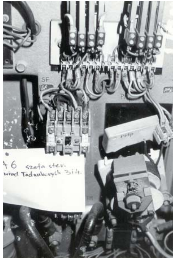
Rys. 14. Uszkodzone elementy ceramiczne we wnętrzu szafy sterowniczej Fig. 14. Damaged ceramic elements inside control cabinet
