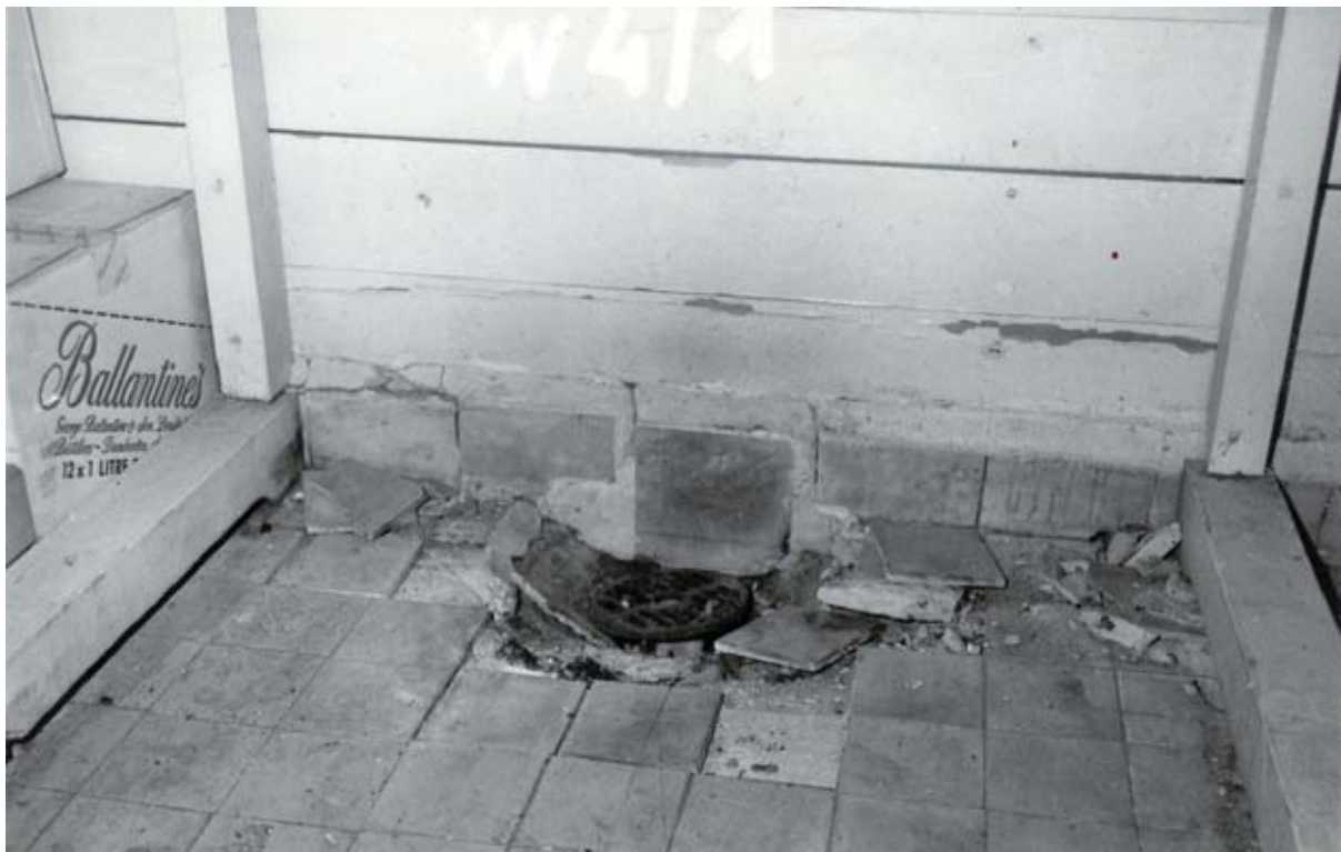
Rys.11. Uszkodzenia podłogi w chłodni Fig.11. Damages of refrigerator floor plate
