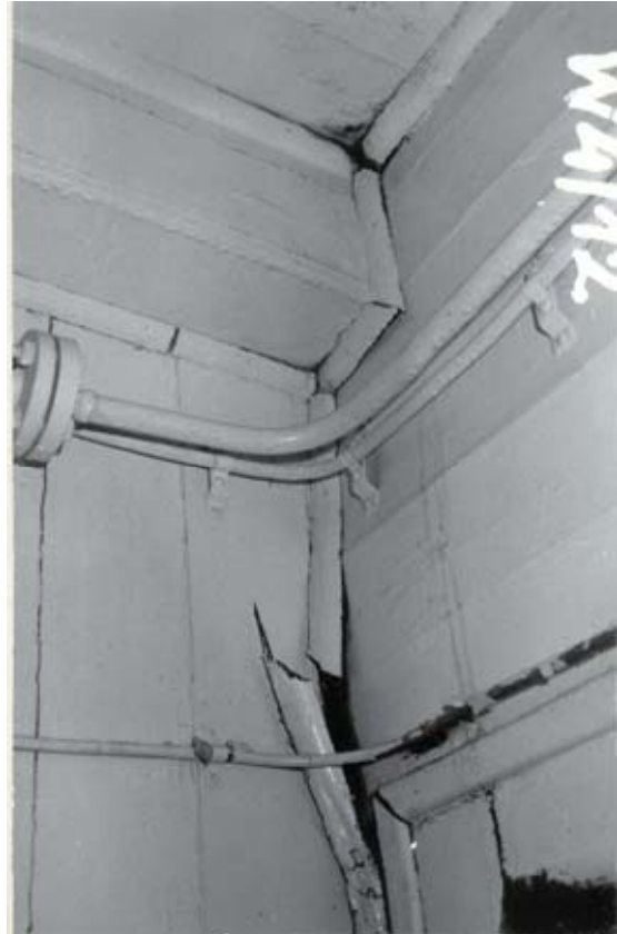
Rys.10. Popękane ściany w chłodni Fig.10. Ruptured walls in refrigerator
