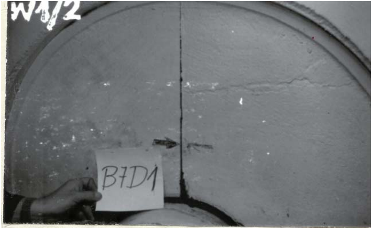
Rys.5. Wygięcie grodzi przy dławnicy wału głównego Fig.5. Contortion of bulkhead near the main shaft
