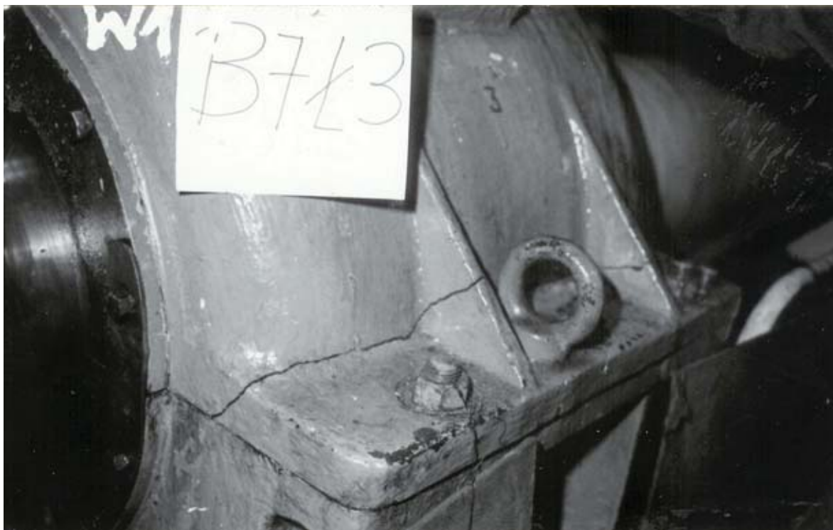
Rys.3. Pęknięcie górnej pokrywy łożyska nośnego linii wałów. Fig. 3. Rupture of upper lid of shaft line carrier bearing.
