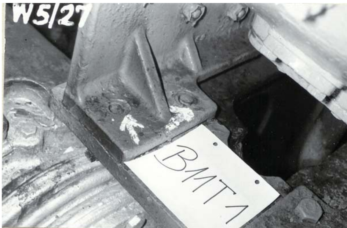
Rys.4. Zerwane śruby mocujące turbodmuchawę silnika Fig.4. Torn camping screws of engine fan
