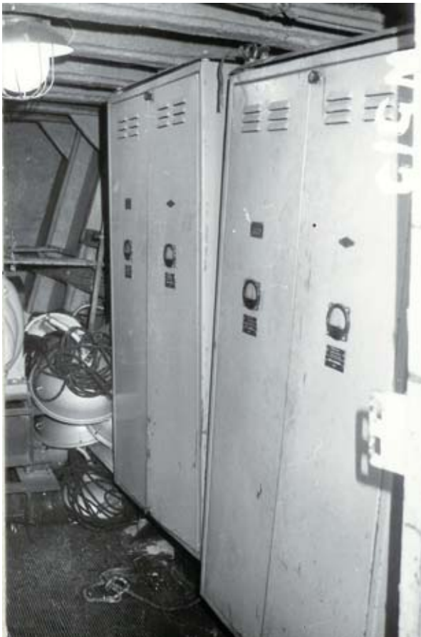
Rys. 13. Zerwane szafy sterownicze wciągarek ładunkowych Fig. 13. Broken off control cabinets of load hosting winches
